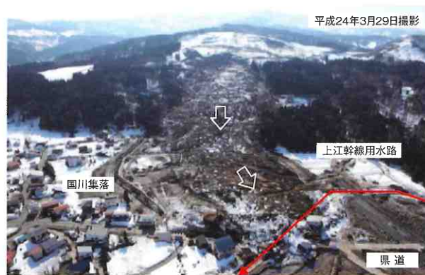
国川大規模地すべり災害(H24.3.7発生) 上江幹線用水路地すべり災害復旧の記録より 関川水系土地改良区(H25.10.31)
