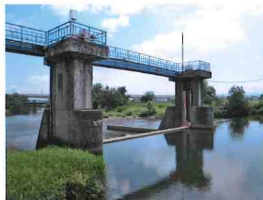
矢代川頭首工(県営)
