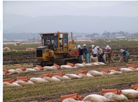
中江北部第2地区の暗渠排水工事の様子
