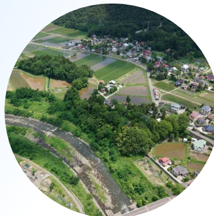
川上繰穴隧道
