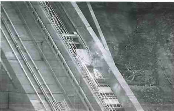
取水ゲート改修（劣悪な条件下で作業を実施）
