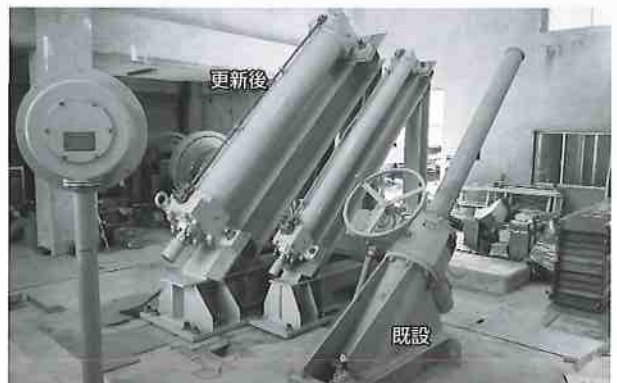
取水ゲート改修（巻き上げ装置の全部更新）
