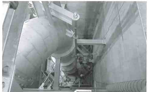
最大放流量を減勢するバルブ（直径1.2m、0.45m）
