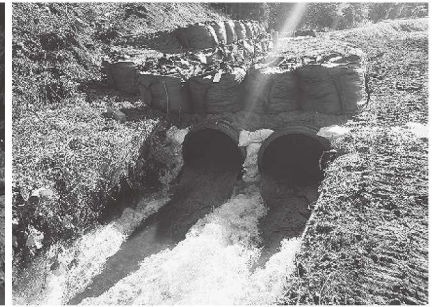
閉塞下流部（応急復旧後）
