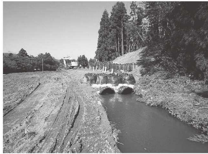
閉塞上流部（応急復旧後）H29.11.7
