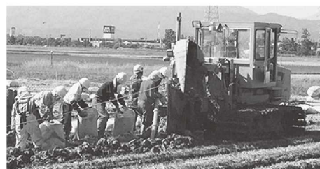
▲トレンチャー掘削機を利用した暗渠排水工事の様子
