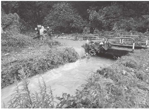
▲澤戸川閉塞による上江幹線用水路への沢水流入（妙高市西条地内）
