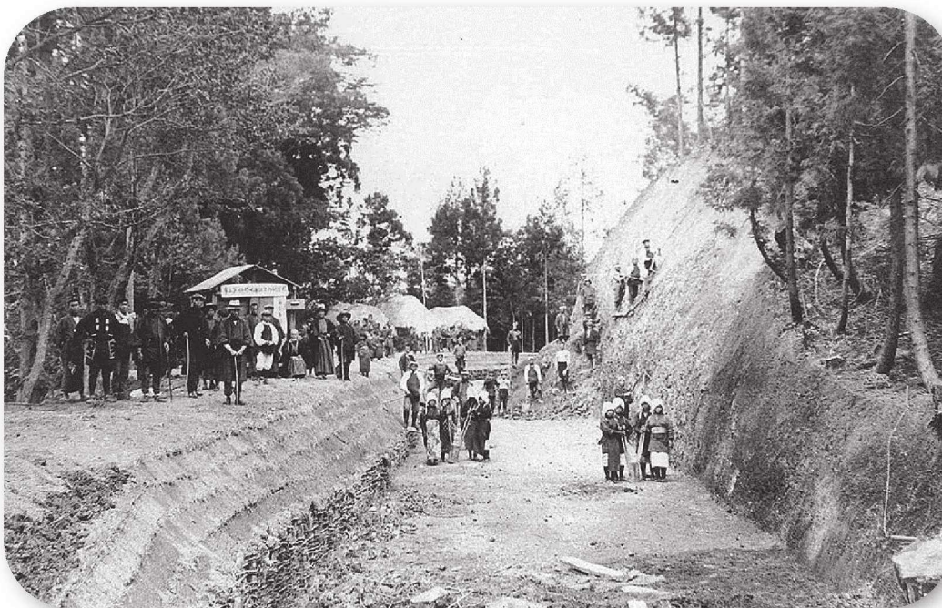
1915年米増地内 上江用水改修工事の様子
