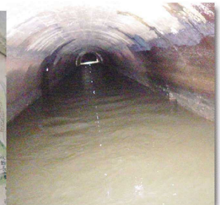
現トンネル(2r=1900mm) 設置:昭和24~35年度 (県営上江用水改良事業)
