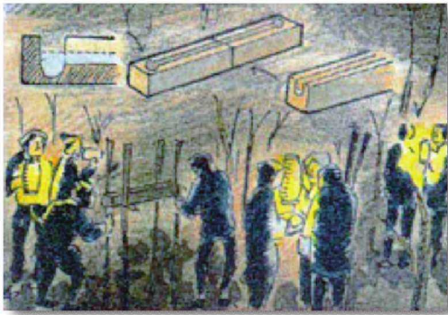
【上江用水の隧道測量の様子】
