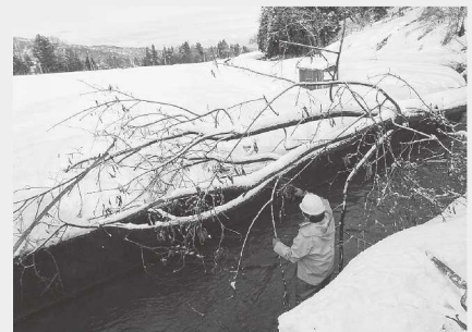
関川右岸幹線の倒木処理 (冬期)
