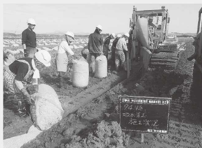
中江北部第2地区暗渠排水工事
