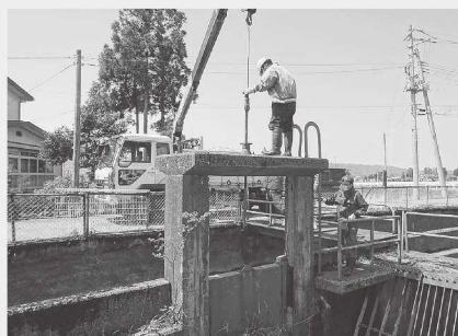
中江幹線のゲート修繕
