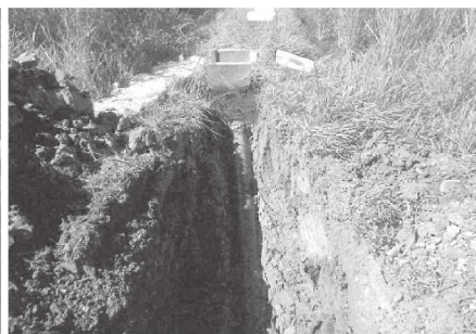
▲排水管漏水対応
