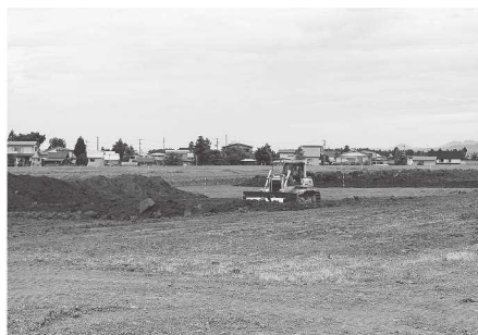
▲高野地区面工事の様子
