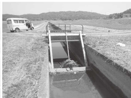
▲水位確保のため角落としを設置
