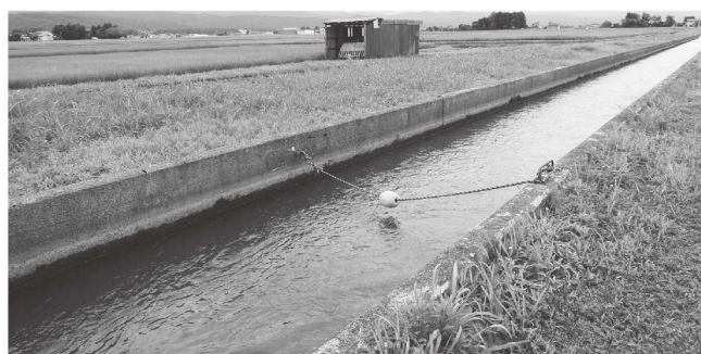
▲用水の通水状況
