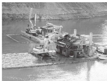
（笹ヶ峰ダム、2台による浚渫）
