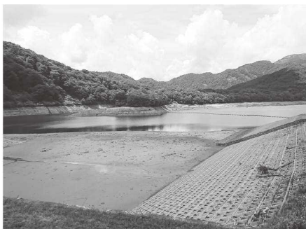
▲笹ヶ峰ダムの水位低下状況
