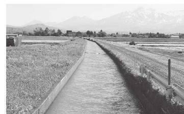
▲用水の通水状況
