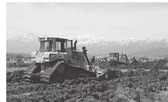
▲高野地区での面工事の様子
