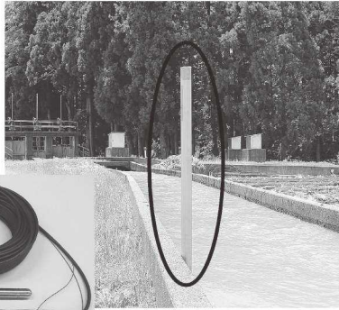
▲水位計設置状況
