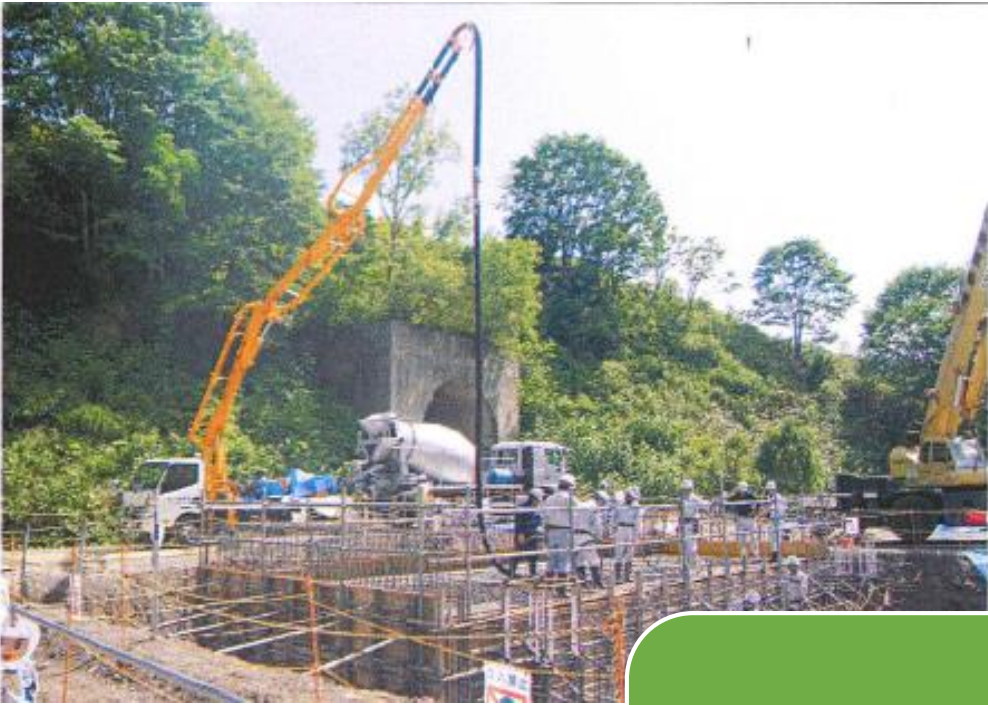
基礎コンクリート打設(発電所上屋)
