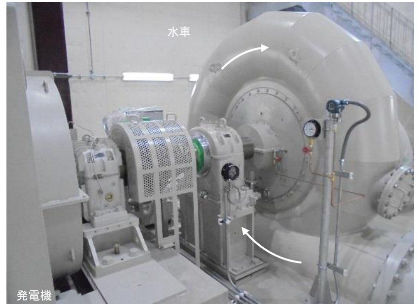
小水力発電設備(H28据付完了)
