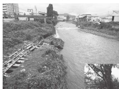
▲波江川西用水取水口付近の被災状況
