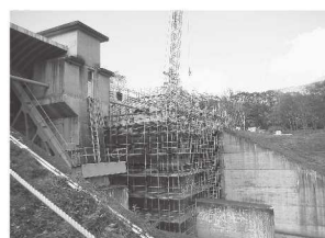
▲笹ヶ峰ダム洪水吐ゲート改修工事
