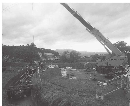
▲上江用水路改修工事（国営事業）の状況
