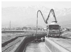
▲中江幹線用水改修工事
