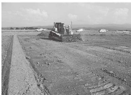
▲ほ場整備事業（面工事）の様子
