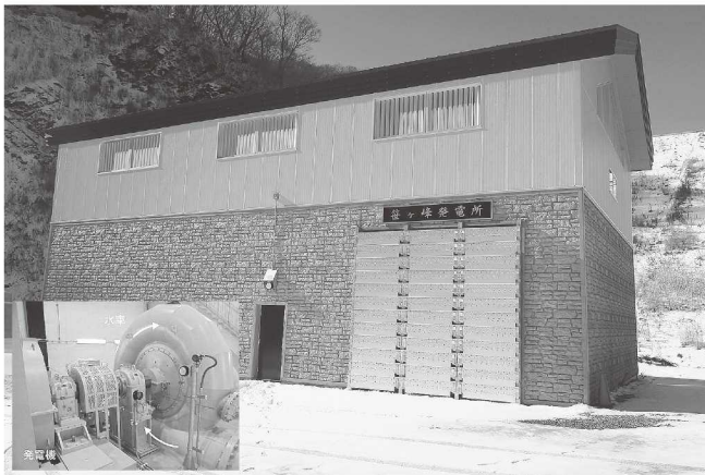
▲稼働中の笹ヶ峰発電所
