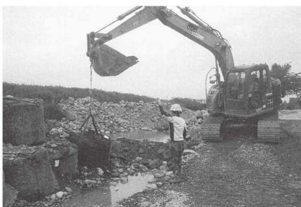
▲上江別所川頭首工護岸復旧工事 (上越市板倉区中四ツ屋地内)
