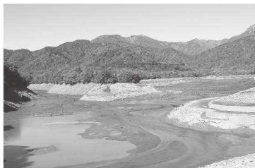
▲笹ヶ峰ダム堆砂状況 （手前：ダム堤体、左：ニグロ川、右：真川）
