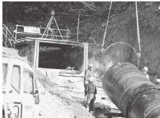
▲上江幹線水路（馬屋サイフォン改修工事）
