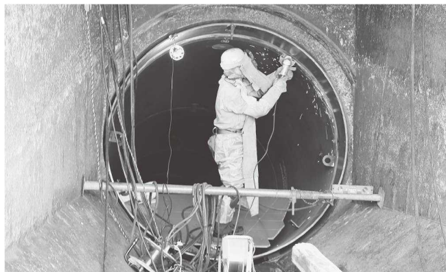
▲中江幹線水路（別所川サイフォン 改修工事）
