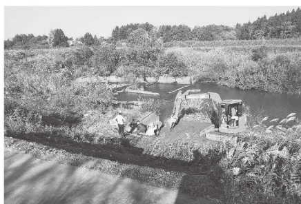
▲保倉中部地区第3号揚水機場配管入替工事 (上越市岡沢地内)
