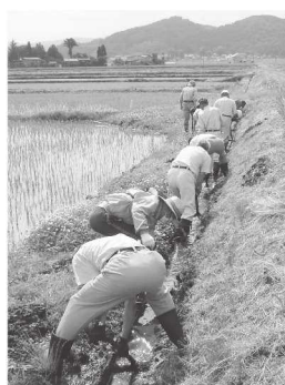
▲水路の泥上げ
