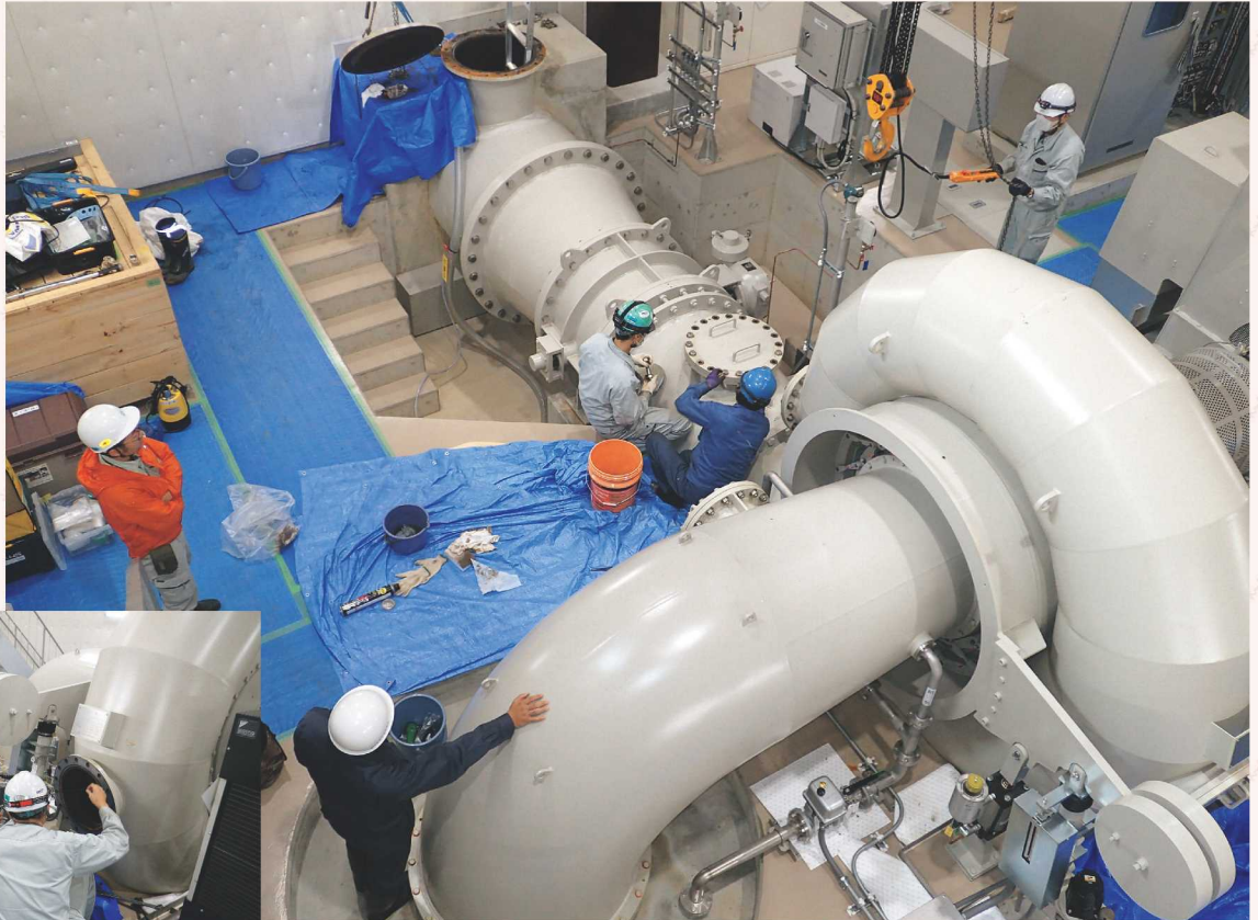
▲笹ヶ峰発電所の点検作業
