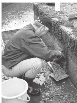
▲水路の軽微な補修
