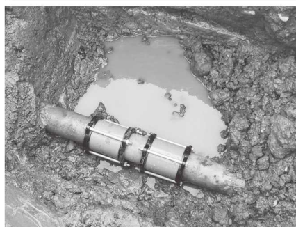
▲パイプライン修繕工事
