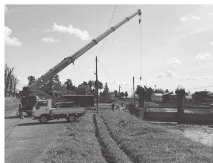
▲笹川頭首工制水門ゲート点検整備工事
