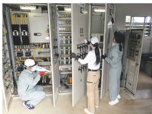
▲配電盤の清掃作業の様子
