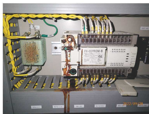
▲自動制御機器から電解溶液の噴出
