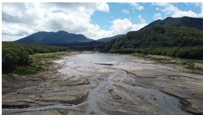
堆砂状況があらわになった笹ヶ峰ダム（真川上流より望む）
