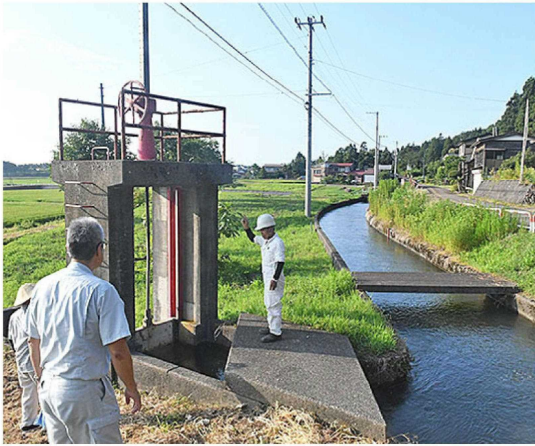
取水制限のためゲートを半分閉める作業（清里区で）
