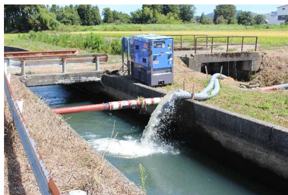
補給ポンプ設置状況（中江幹線用水路）
