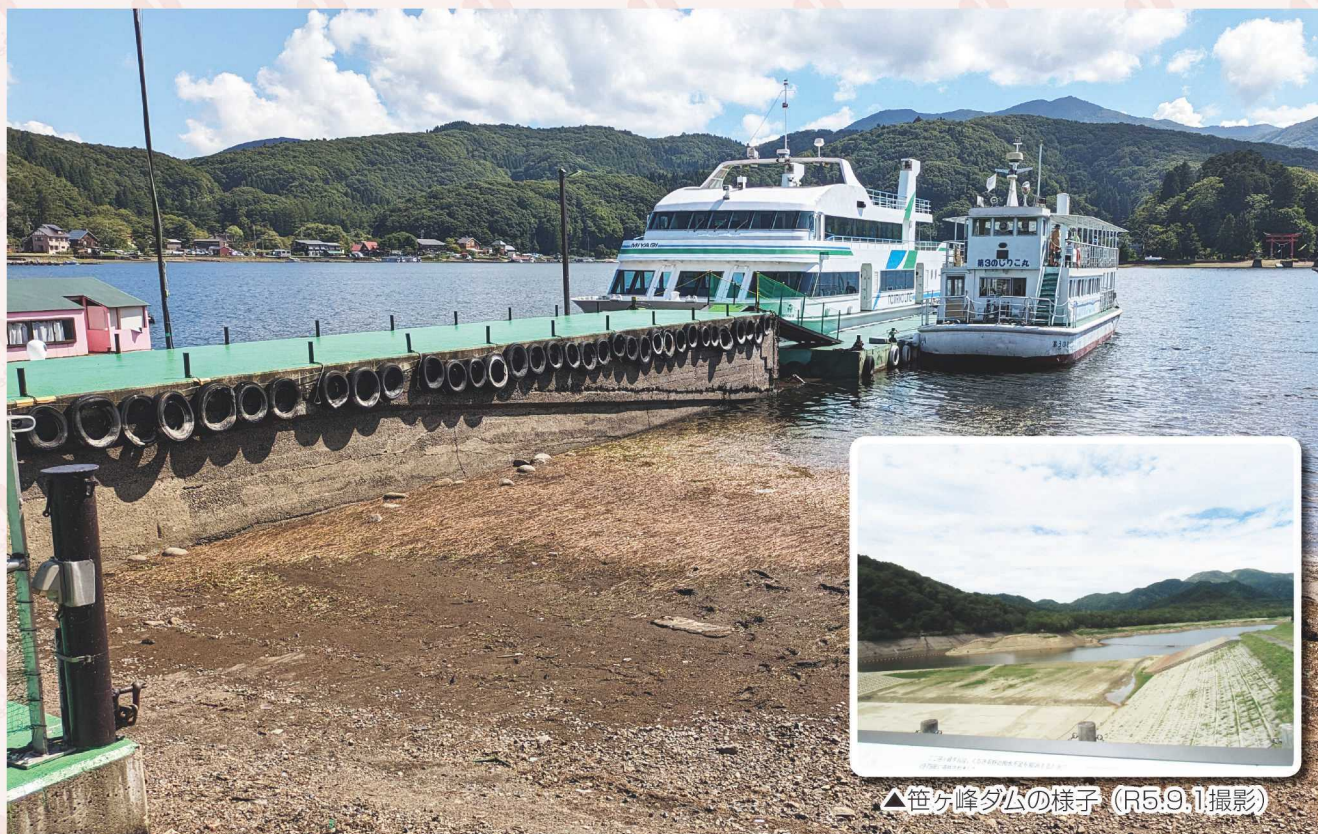
▲野尻湖水位低下により栈橋がむき出しになっている様子 (R5.8.27撮影)
