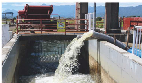
中江別所川サイフォン（上越市板倉区長嶺地内）排水路からポンプで水を汲み上げている様子
