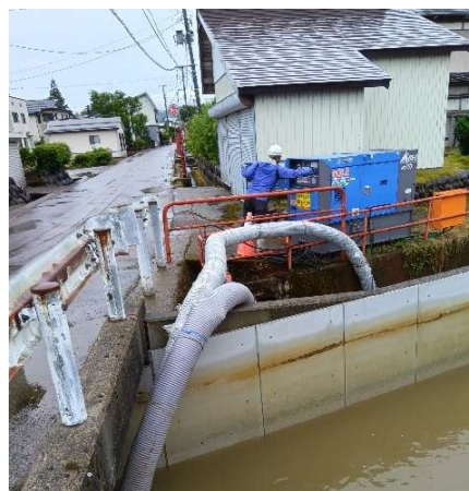
補給ポンプ設置状況（中江幹線用水路）
