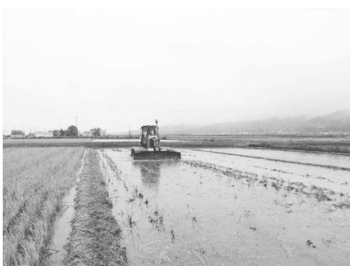
▲上越市干ばつ災害水田復旧事業 (亀裂の入った田を湛水整地により復旧)
