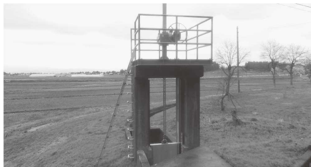
▲国営事業で改修された六寸樋分水ゲート
