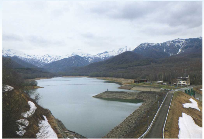
▲笹ヶ峰ダムの積雪状況（R8.4.30 時点）
