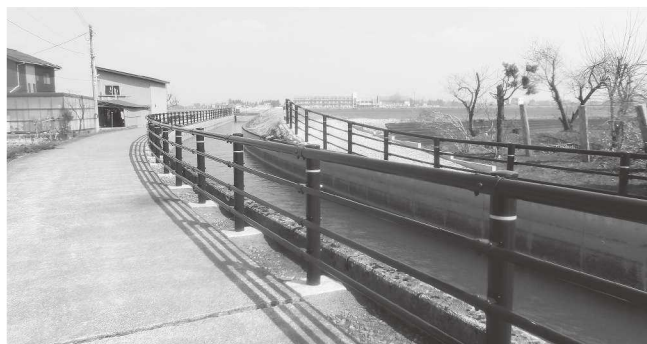
▲国営事業で改修された転落防護柵（板倉区高野地内）
