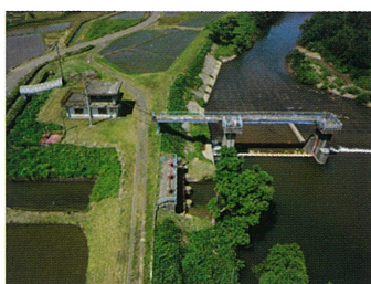
県営 矢代川頭首工（現況）
