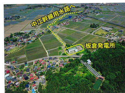
最末端の板倉発電所 東北電力（株） 発電後の用水は、上江、中江用水として利用
