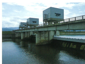
国営関川頭首工 平成7年7月災害復旧関連で改修
