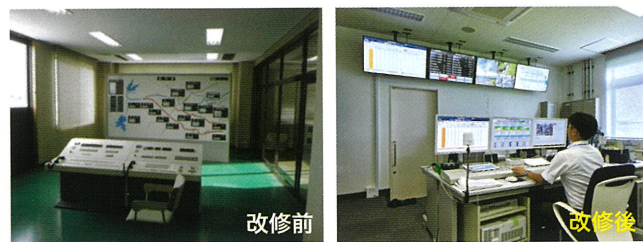
水管理システムの改修
