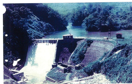
水没した電力用の笹ヶ峰共同貯水池
