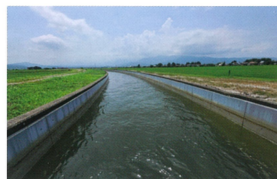
中江幹線用水路中流部
