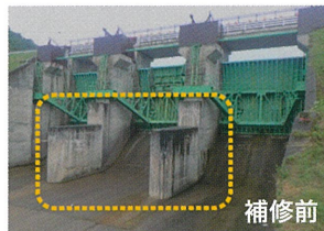
洪水吐ピア（下流側）
