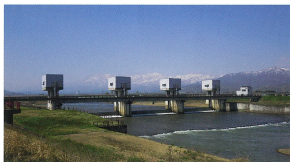
稲荷中江用水の取水源の関川頭首工
