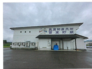
雪室貯蔵施設
