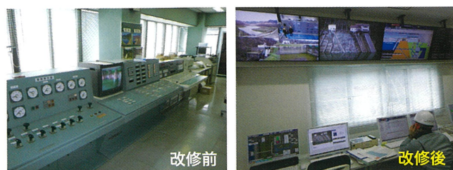
ダム管理システムの改修
