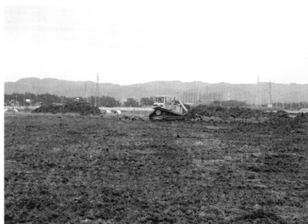
▲面整地工 (中江北部第2地区：上越市下野田地内)
