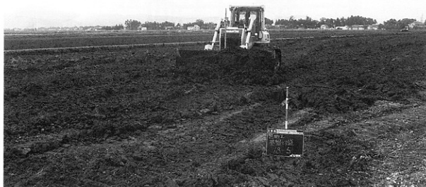
▶面整地工（津有南部第1地区・上越市下新町地内）
