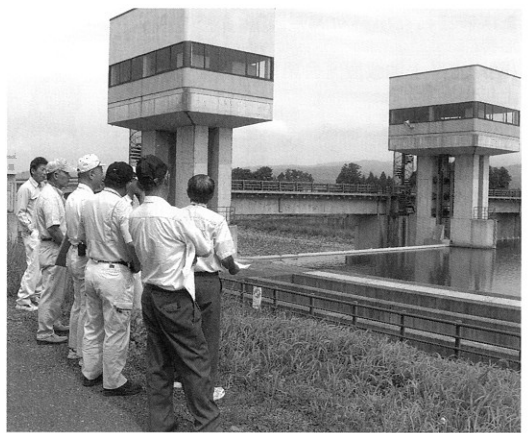
関川地区土地改良区連合経営検討委員による現場踏査 (上)字頭首工、和田土地改良区管理・妙高市(広島地内)
