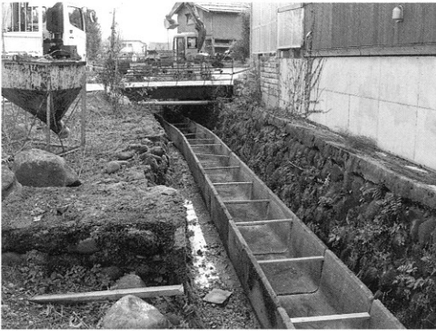
▲ベンチフリューム敷設工 (上越市稲地内)
