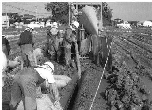
▲暗渠排水工 (三和西部地区：上越市三和区島倉地内)
