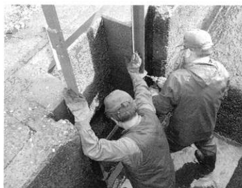
▲ゲート改修工事 (上越市駒林地区内)
