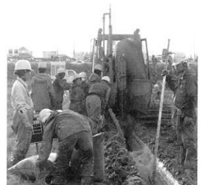
▲新道地区暗渠排水工事（上越市富岡）
