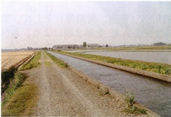
▲水利用実態調査が予定されている中江幹線用水路(上越市板倉区高野)
