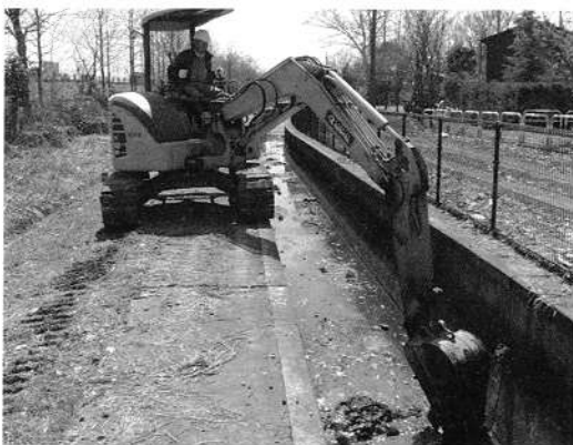
▲浚渫作業(H23.4) (大道子安幹線用水路:上越市子安地内)
