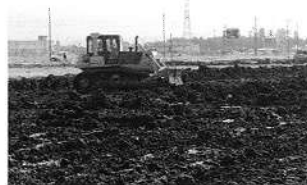
▲面整地工の状況 (中江北部第2地区:上越市上野田)
