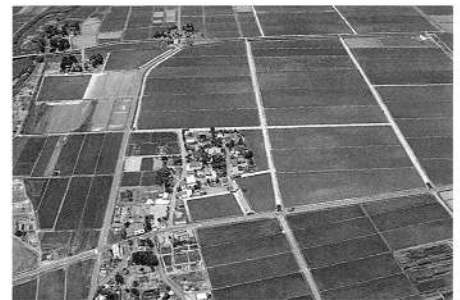
▲完成した高士西部地区のほ場
