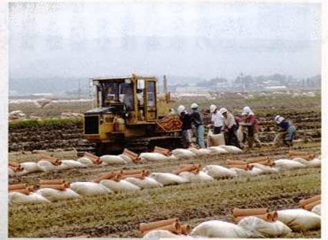
▲吸水管(素焼土管)及び疎水材(モミガラ)の布設状況
