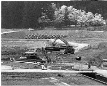
◀ 土中に埋設され完成した仮回し水路
