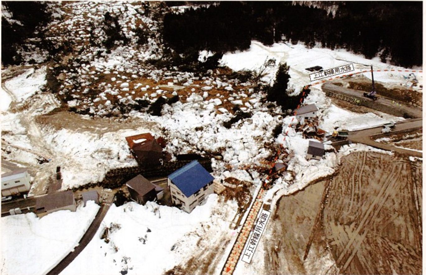
▲大規模な地すべり災害により被災を受けた家屋と上江幹線用水路(上越市板倉区国川地内)
