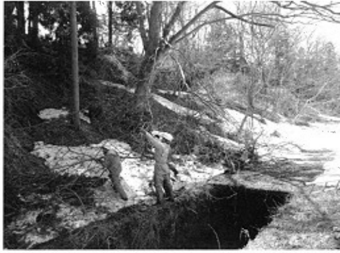
▲倒木撤去作業 (上江幹線用水路：上越市板倉区山部地区)
