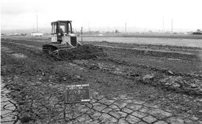
▲ 面均平整地工 (津有南部第1地区：上越市藤塚地内)
