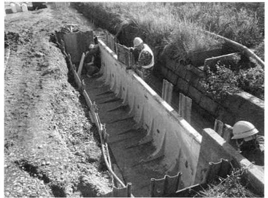
▲排水路補修 (上越市本道)
