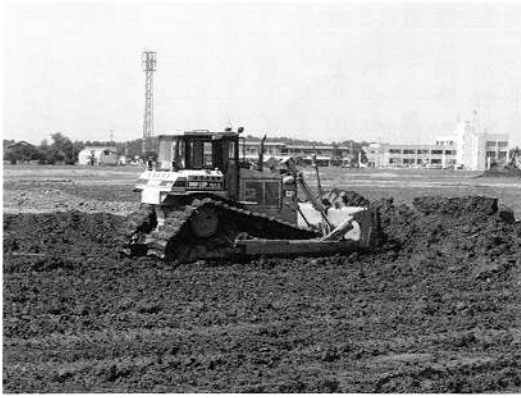
▲面整地工事（上越市三和区田内地内）
