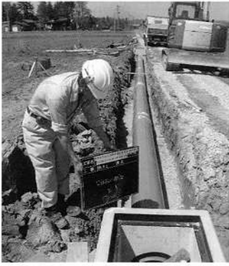
▲排水路切替 (上越市中田新田)
