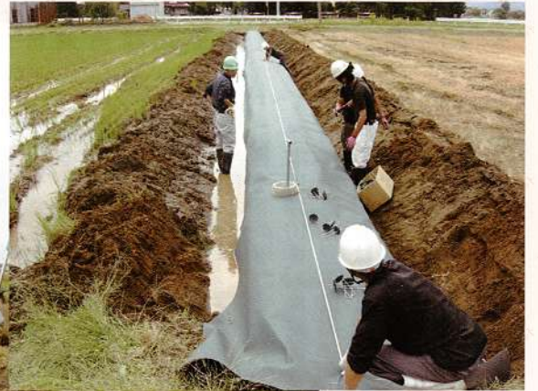
▲防草シートをピンで固定する作業員 (津有南部第2地区:上越市稲地内)
