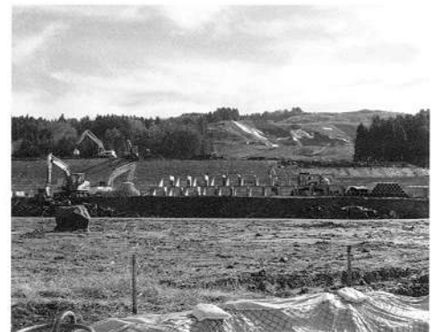
▲急ピッチで進む災害復旧本工事 (上越市板倉区国川地内)
