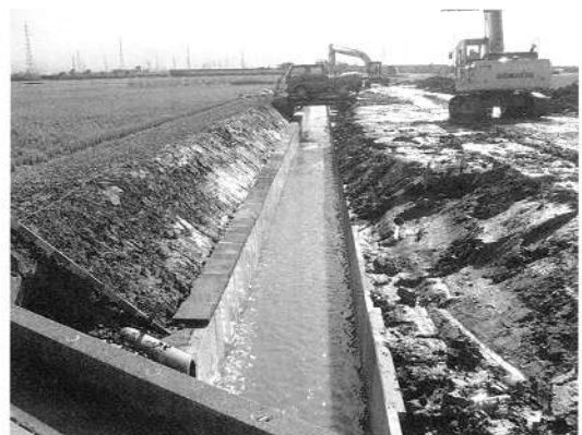
▲排水路改良工事（上越市三田）
