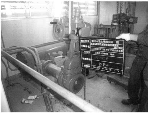
▲可変速ポンプ吐出弁修繕 (上越市駒林)
