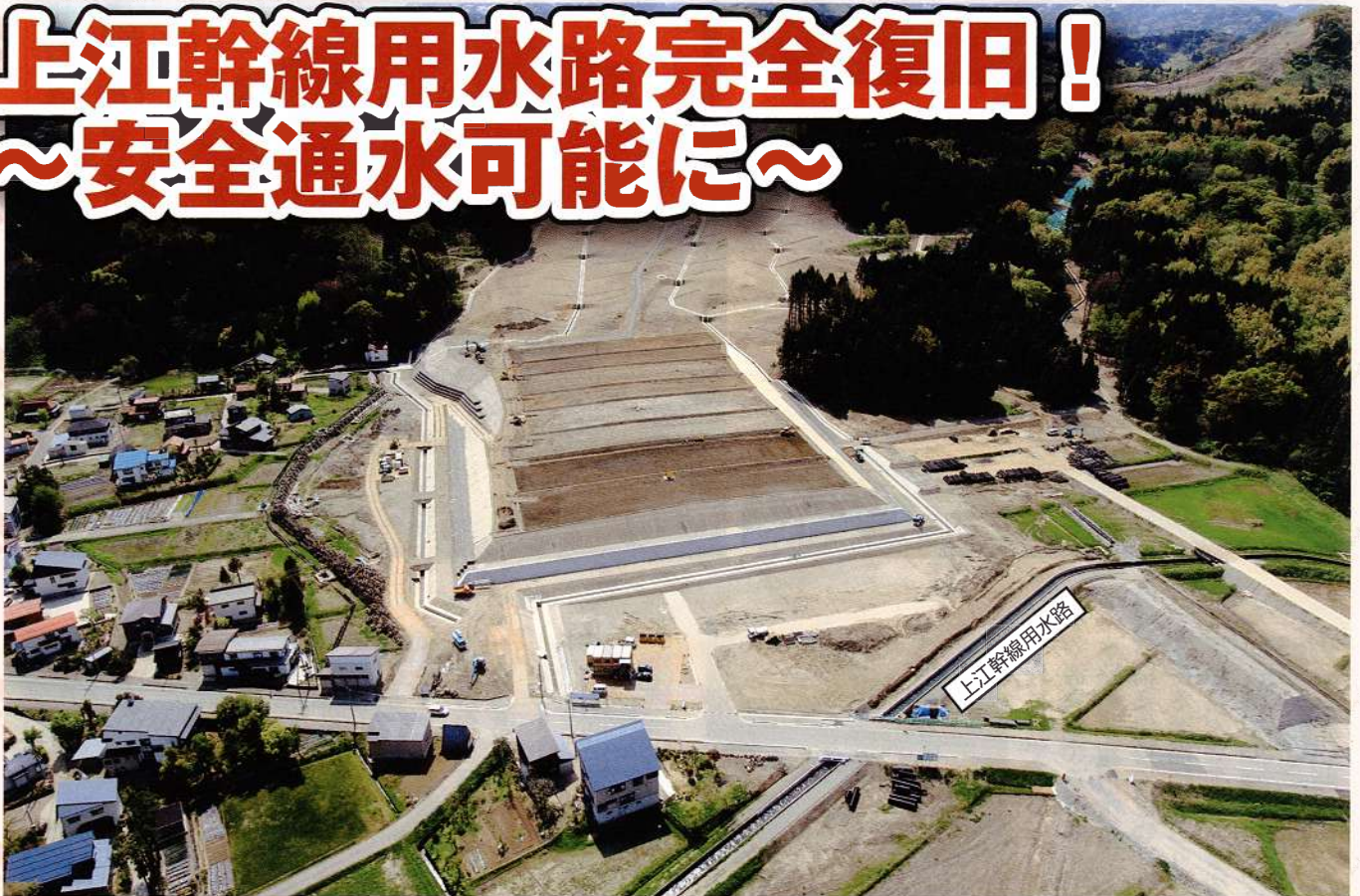
地すべり災害復旧工事の全景（上越市板倉区国川：平成25年5月9日現在）
