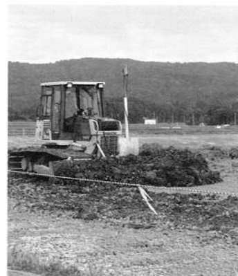
三和南部地区の工事の様子
