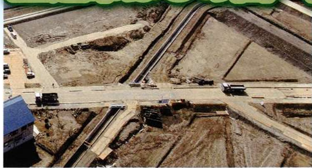
▲復旧工事で通水が可能となった上江用水路
