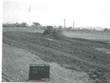
▲県営ほ場整備事業 津有南部第2地区 面工事(東稲塚新田)
