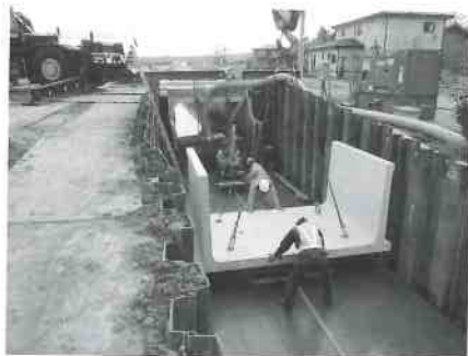
▲県営ほ場整備事業 中江北部第2地区 排水路工事(桐原)
