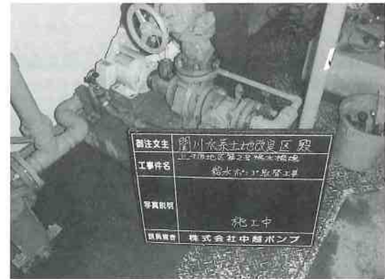
▲給水ポンプ取替 (上千原地区第2号揚水機場)
