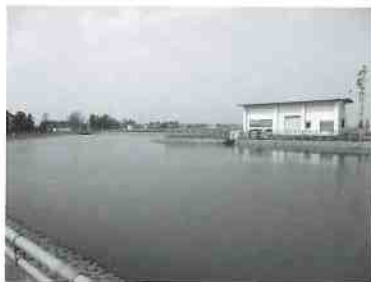
▲津有南部第1地区揚水機場
