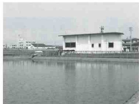
▲三和西部地区井ノ口地内揚水機場
