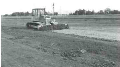
▲中江北部第2地区荒屋地内整地工事
