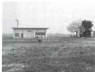
▲太陽光発電を要望している野尻地内揚水機場
