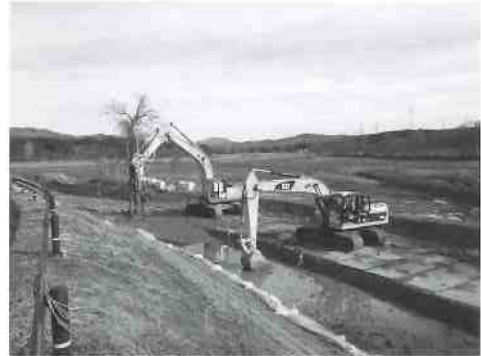
▲青野地区ため池の盤改良工事の様子
