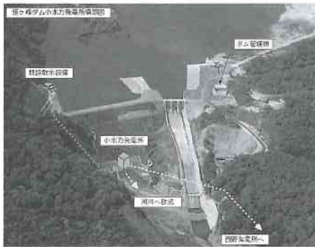
▲国営事業で小水力発電所建設が予定されている笹ヶ峰ダム
