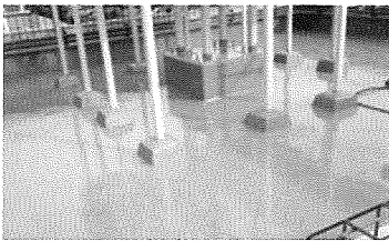
▲ダム管理棟屋上をウレタン塗膜防水で改修
