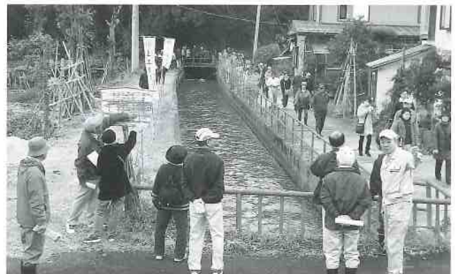
▲川上線穴隧道
