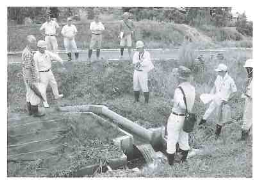
▲三和南部地区工事現場立会い
