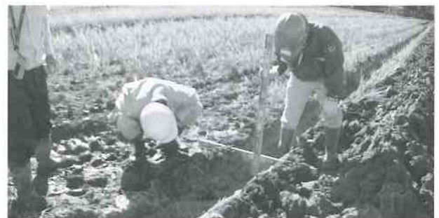
▲津有南部第1地区にて暗渠排水工事立会い
