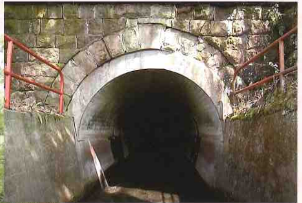
▲川上線穴隧道入口
