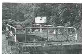
▲石積み水路跡
