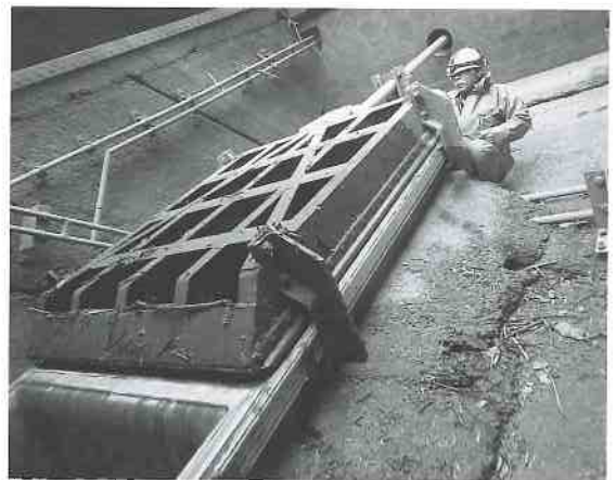
▲笹ヶ峰ダム取水設備点検作業
