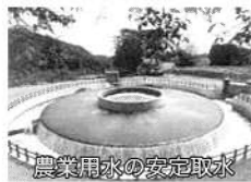
農業用水の安定取水
