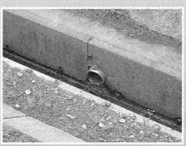
写真③ 鉄分が付着した暗渠排水口
