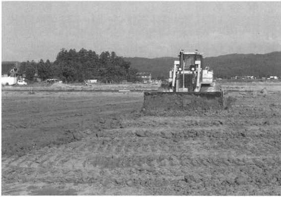
▲進捗が遅れているほ場整備事業（三和区川浦地内）
