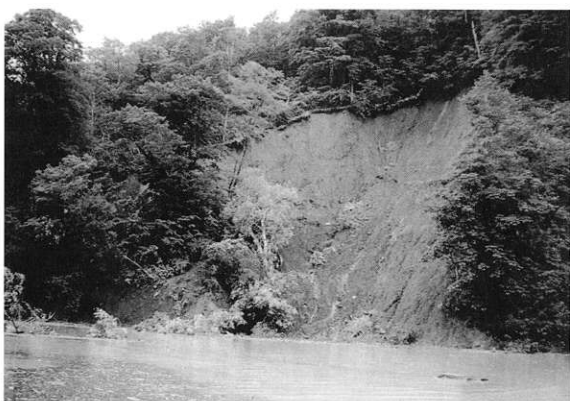
▲7.11水害による地すべり状況（笹ヶ峰ダム）
