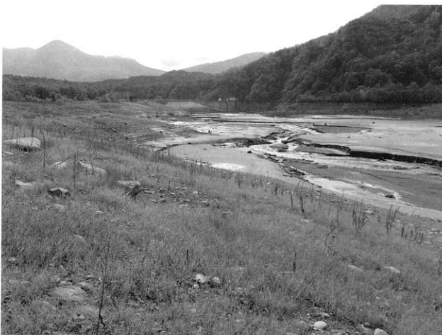
▲真川の堆砂状況 (N0.2+200付近から下流部を望む) 正面が笹ヶ峰ダム堤体 (現場で約3mの堆砂)
