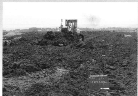
急ピッチで進む面整地工 (中江北部第2地区：上野田市内)
