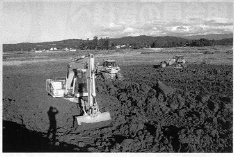
▲ほ場整備事業の状況(三和南部地区：上越市三和区窪)
