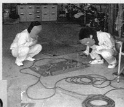
▲溶接作業をする高校生
